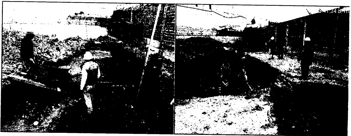
Foto N° 21 Y 22: Vista General de los Trabajos realizados en area de PTAR, excavaciones y construcción de solado de sedimentador secundario, reactor biologico, camara de rejillas, trampa de solidos, camara de bombeo N° 02.
