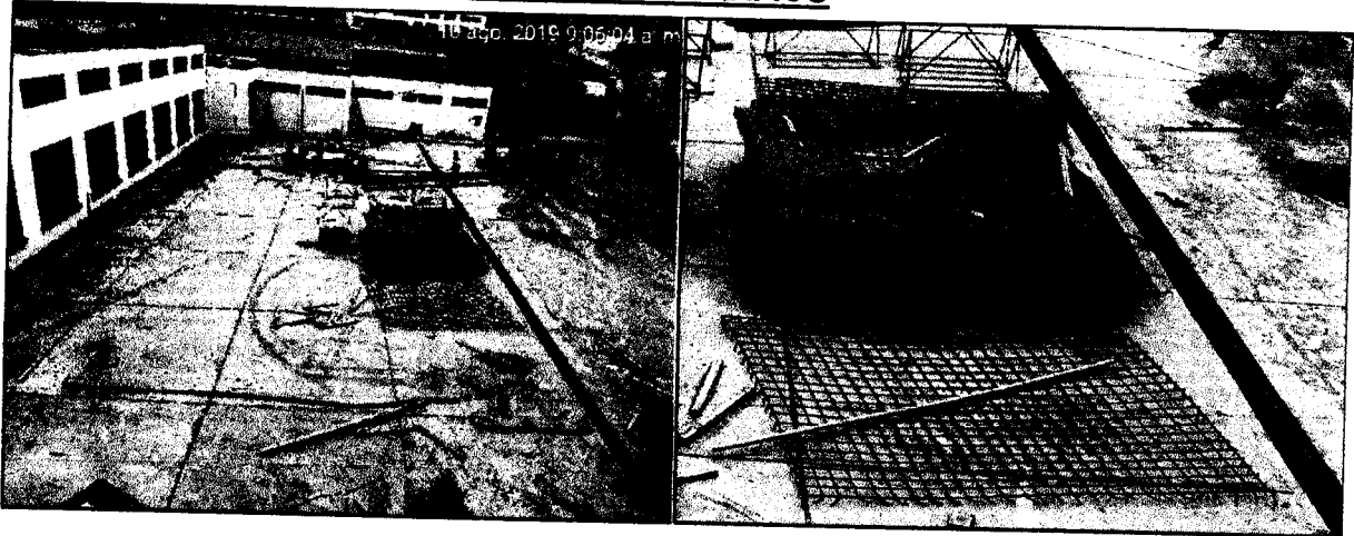
Foto N° 01 y 02: Encofrado en area de losa aligerada del primer nivel del area de Administración.
