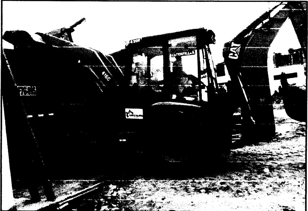
Fig. 02 Eliminación excedente proveniente de la excavación del área de PTAR.
