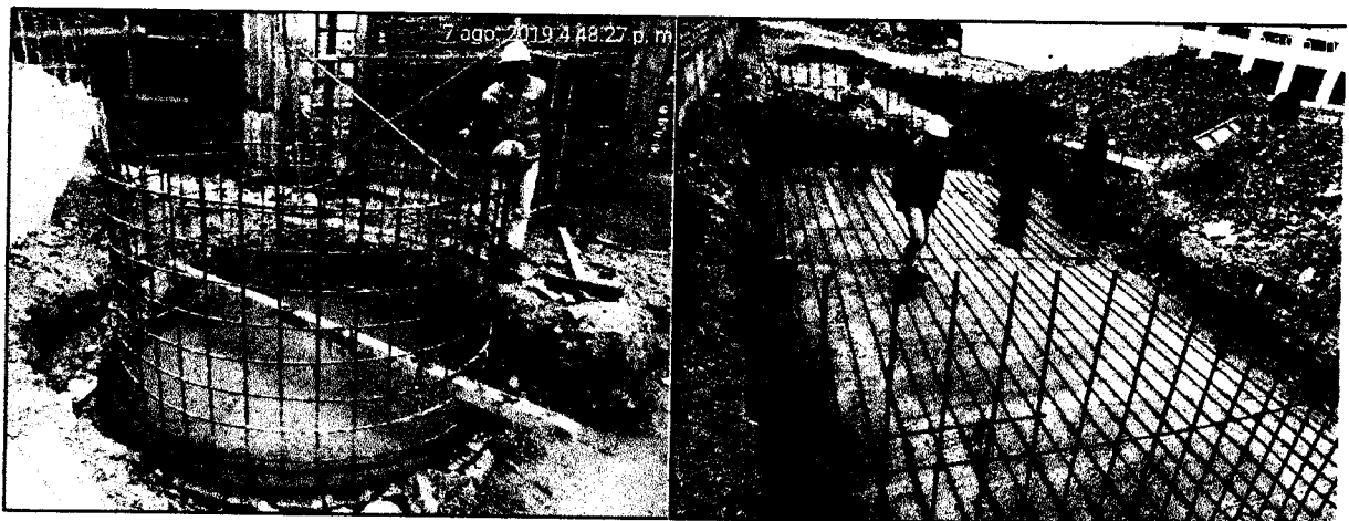
Foto N° 23 y 24: Vista General de los Trabajos realizados en area de PTAR, armado de acero para la construcción de sedimentador secundario.
