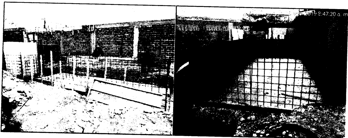
Foto N° 29 y 30: Vista General de los Trabajos realizados en area de PTAR, armado de acero y encofrado para la construcción del reactor biológico.
