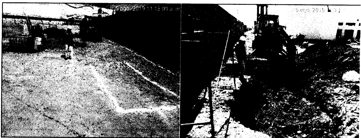
Foto N° 17 y 18: Vista de los Trabajos realizados en area de PTAR, trazo, replanteo y excavacion para construcción del Reactor Biologico y sedimentador secundario.
