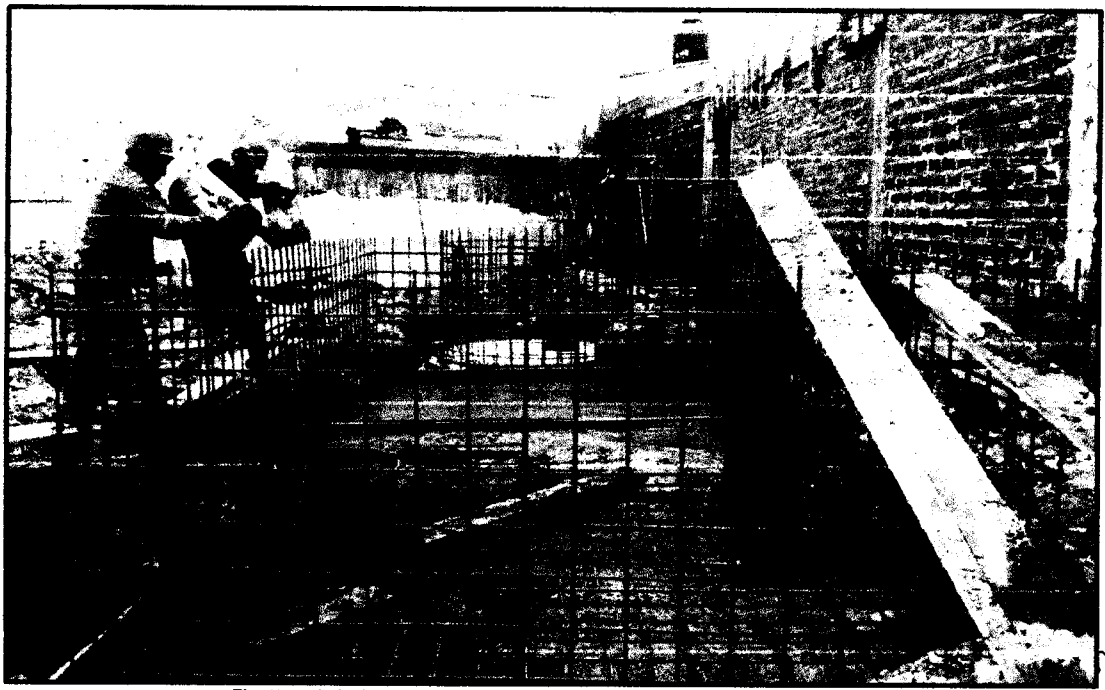
Fig. 07 vaciado de concreto f'_c=210 \text{ kg/cm}^2 en reactor biológico del área del PTAR
