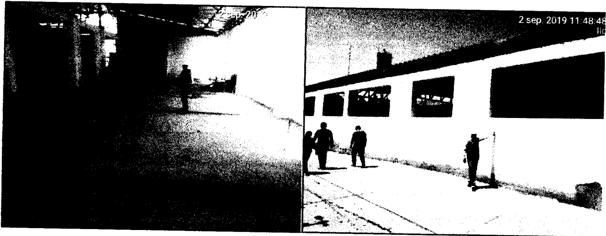
Foto N° 43 y 44: Partida N° 02.01.07.02, "PINTURA EN PISOS CON EPOXICO" y N° 02.01.07.03, "PINTURA EN MUROS Y COLUMNAS EXTERIORES CON EPOXICO", que intentaron sorprender ser valorizadas sin ejecutar: en este sentido se muestra fotos del area sin observarse trabajos valorizados.
